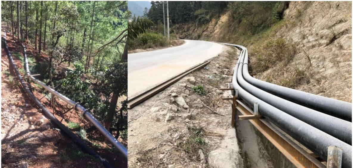
图 6 某矿山共挤耐磨层钢丝增强塑料复合管和钢衬胶耐磨管铺设的管路现场照片
